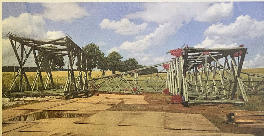
Bei Mast 105 zwischen Bockenem und Schlewecke müssen noch die Einzelteile mit einem Kran montiert werden.
