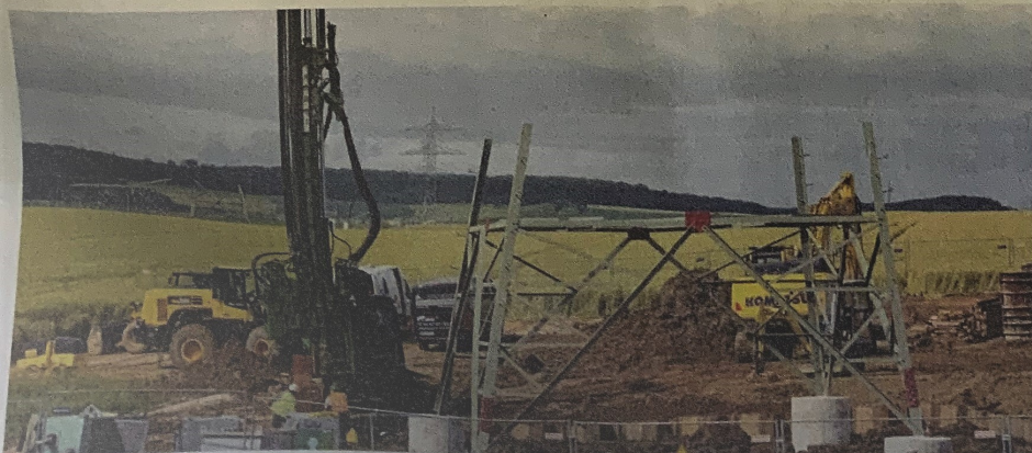
Während einige Masten bereits bis zu 60 Meter in die Höhe ragen, müssen bei anderen zunächst die Erdarbeiten beendet werden.
